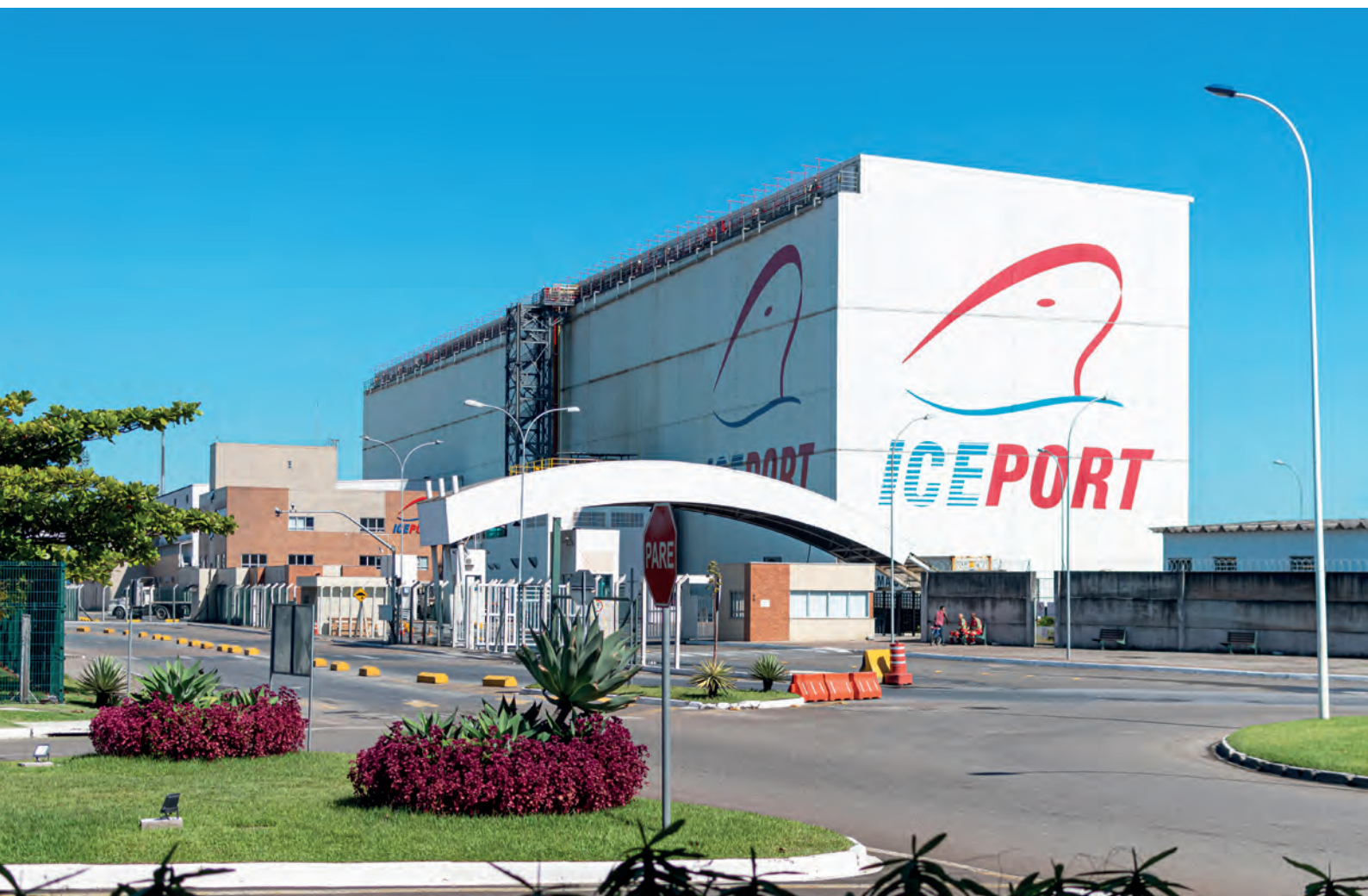
A Iceport oferece soluções em logística para importações e exportações e uma câmara frigorífica totalmente automatizada
